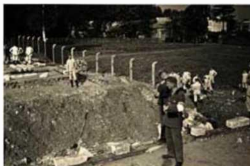
Rys. 126. Naprawa mostu na Sarnim Stoku
