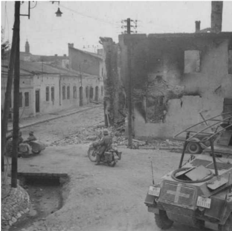
Rys. 132. Wjazd niemieckiej kolumny pancernej do zbombardowanych Żarek.
