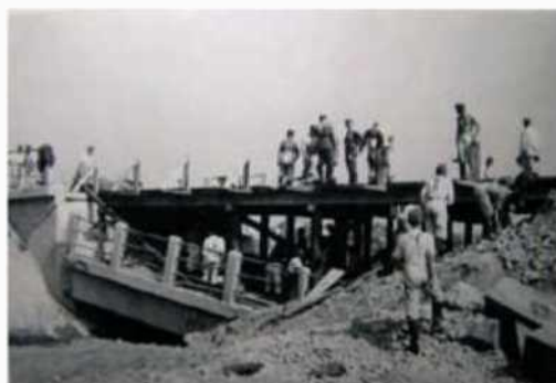
Rys. 125. Naprawa mostu na Bożym Stoku
