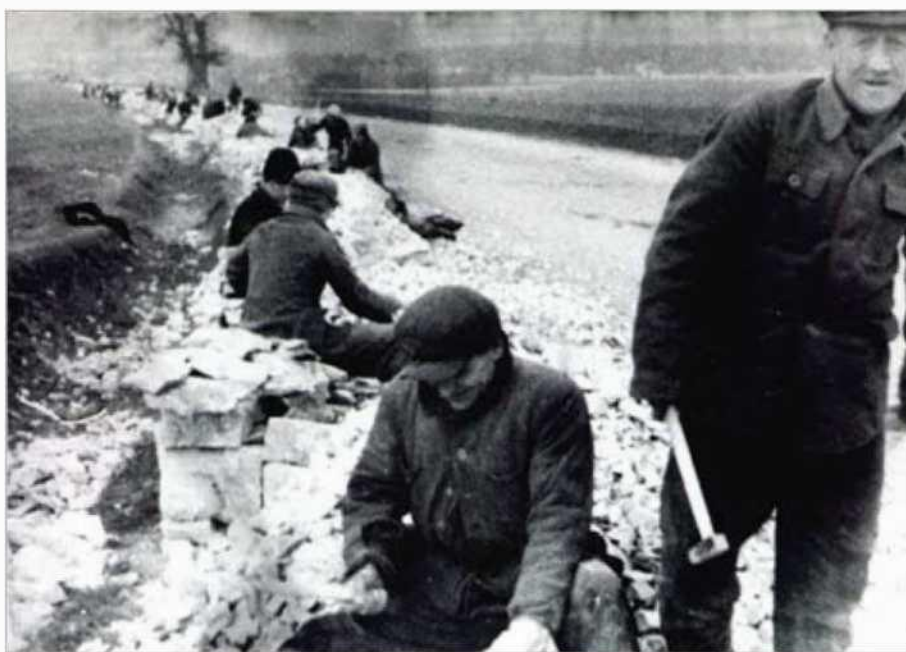
Rys. 138. Naprawa drogi w Żarkach.
